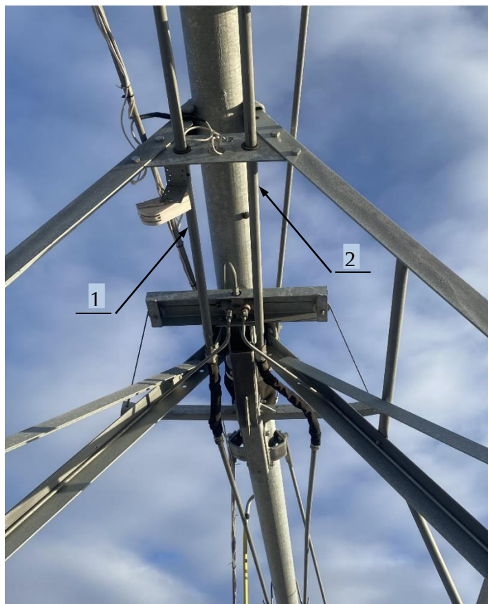
Рисунок 2 – Фрагмент несущей фермы опорной башни с маслопроводом
